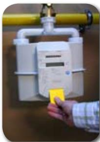
Qu'on l'appelle compteur à carte ou compteur à budget, il s'agit toujours du même appareil. Concrètement, il s'agit d'un compteur gaz équipé d'un boîtier électronique qui permet la lecture d'une carte à puce.
